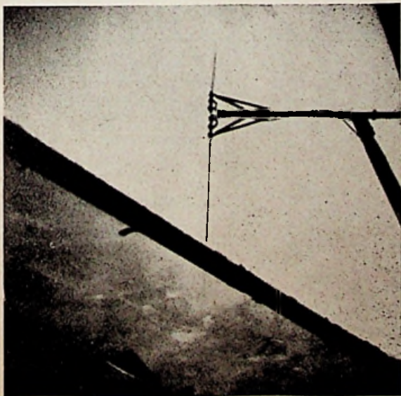
DIRECTOR EN TEGENGEWICHT. — Men onderscheidt duidelijk de 6 meter lange coaxiale kabel die de antenne met de antennevoorversterker verbindt.
